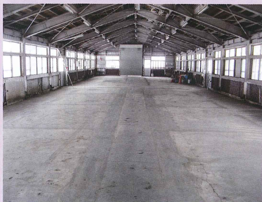
雨天実習場・機材保管庫(旧豚舎)
